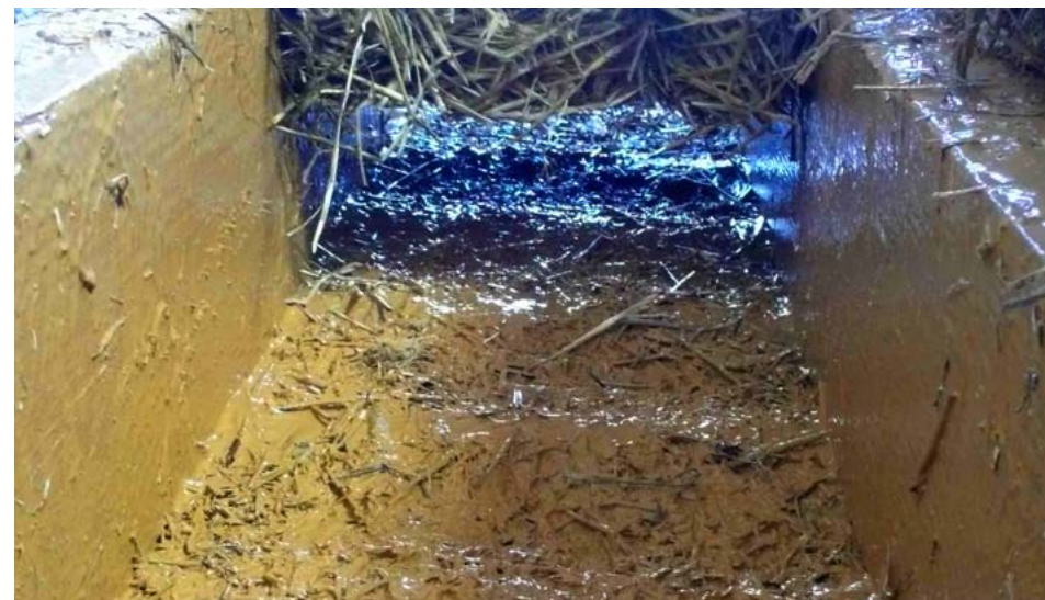
Module pédagogique d'isolation de plancher en botte de paille et terre Chantier-école (Strée - Belgique)
