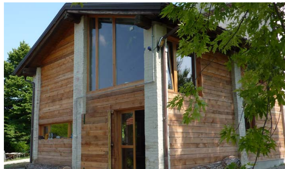
Casa Romitelli : Transformation d'une grange en maison avec des murs en bois - Marco Zini
